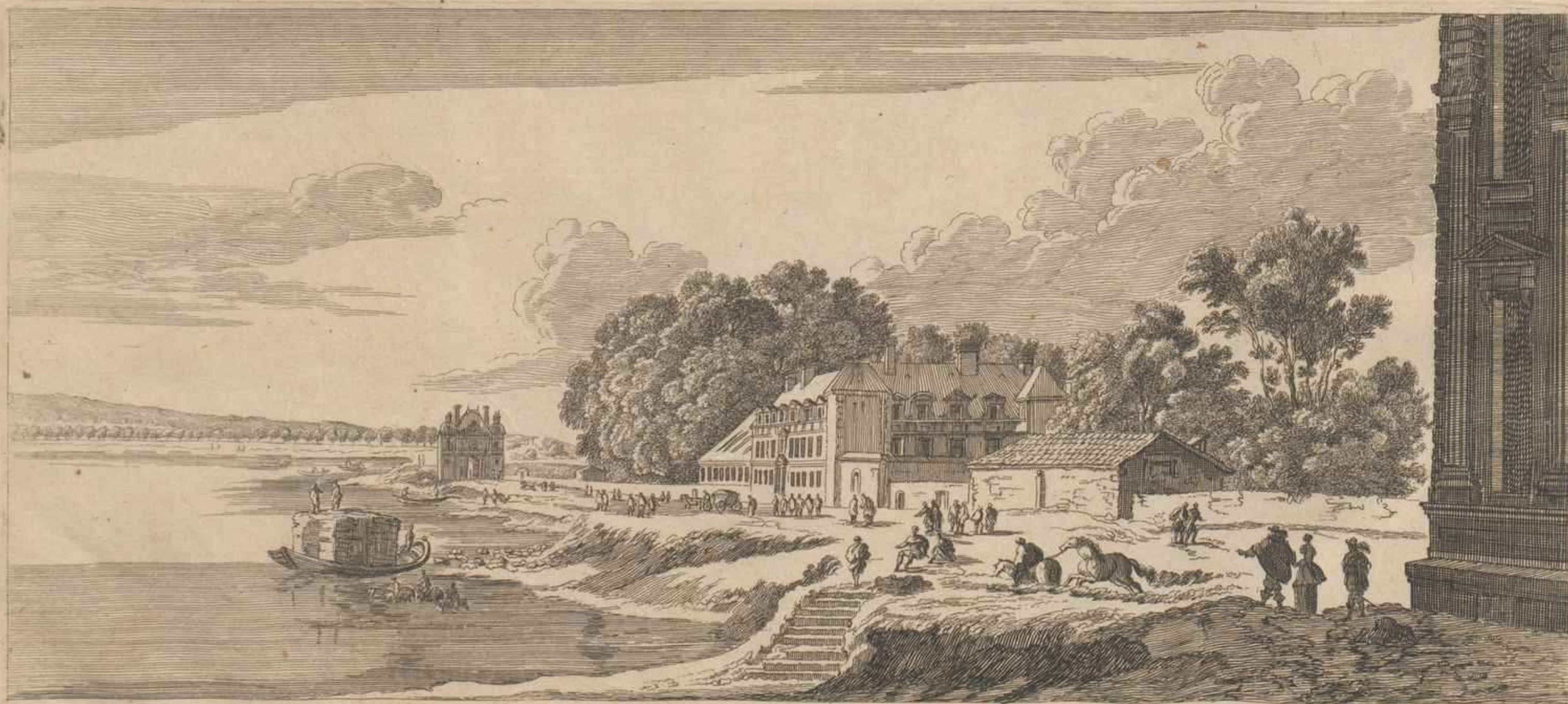
Vue et Perspective du Jardin de Tuilleries et de la Porte de la Conference.
